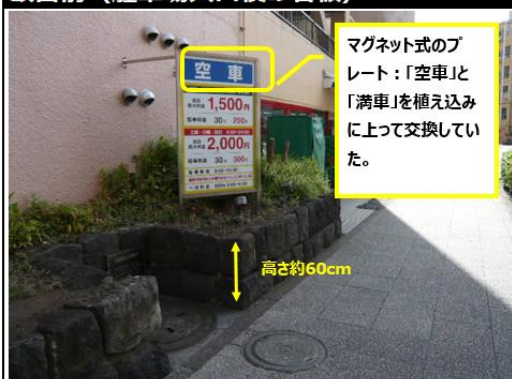
改善前（駐車場入口横の看板）
