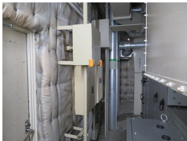
ウレタンクッション取付後の全景
