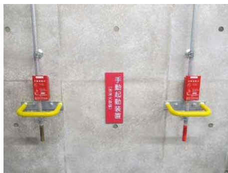
手動起動装置に保護ガードを設置
