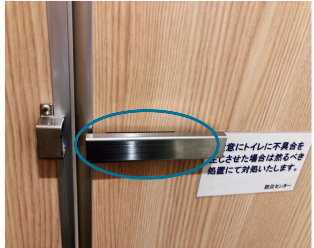
写真18 女子トイレ個室 ・内鍵金属部分を拭き取り
