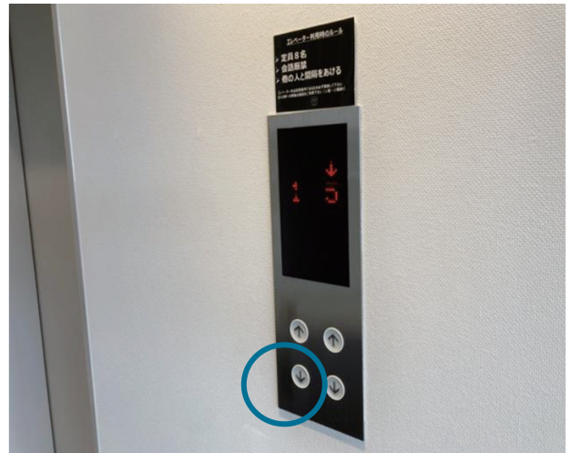
写真20 エレベーター ・外側下り押しボタン (拡大)
