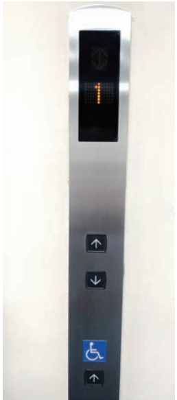
写真 1 エレベータ昇降ボタン
