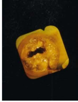
管カメラ調査：屋内給水管
