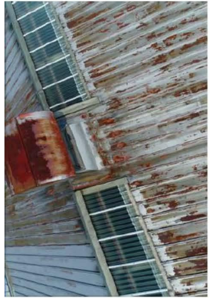
工場屋根・撮影写真
