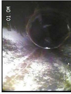
管カメラ調査：屋外排水管
