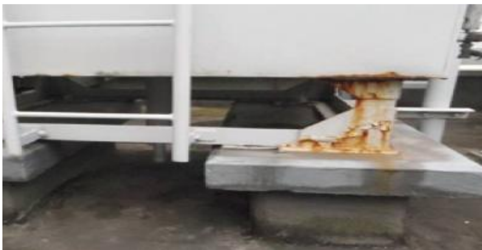
状況 11 : 屋上の膨張タンクの架台に発錆
