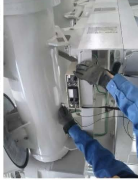
【A Eセンサーによる部分放電、並びに異物等の検出】
