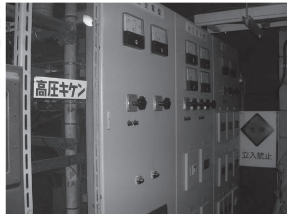
屋内オープンフレーム式受変電設備
