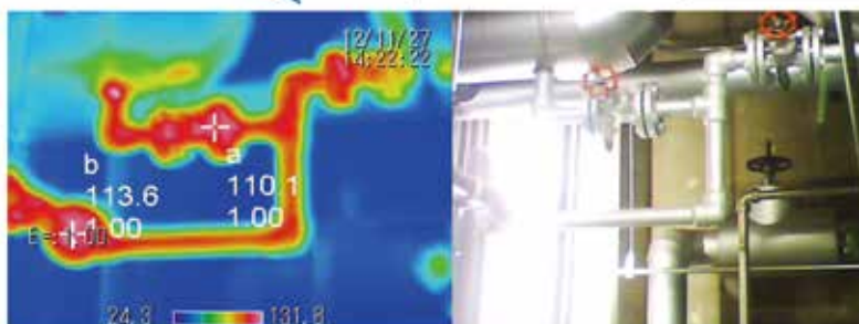
サーモビュー撮影事例
