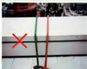
切断防止措置が取られていない危険な事例
