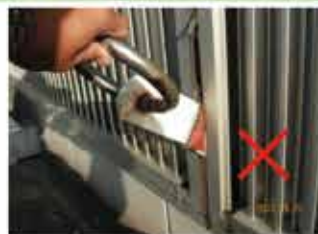
亀裂が入った危険な支持物の例
