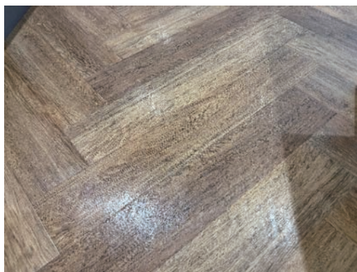
写真11 施工されている床材
