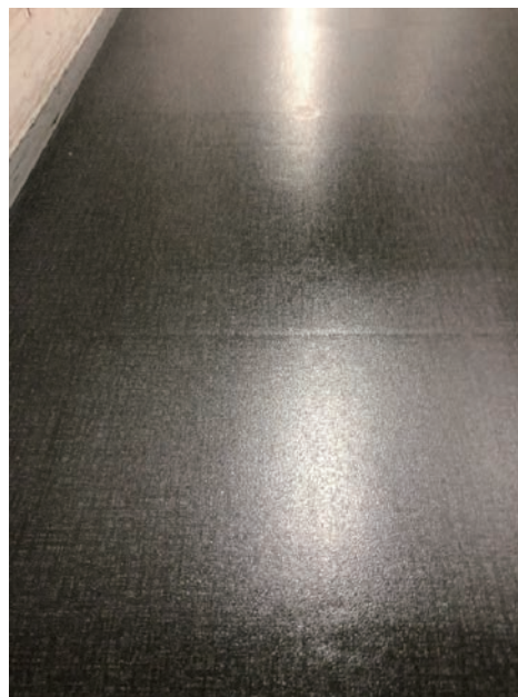
写真31 ノンワックス床拡大写真 樹脂ワックスは塗布していませんが、十分な光沢があります。
