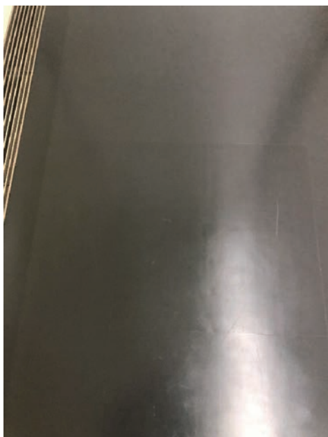
写真28 樹脂ワックス塗布面に、 若干の凹みがある
