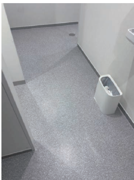
写真32 ノンワックス床敷設箇所 (トイレ)
