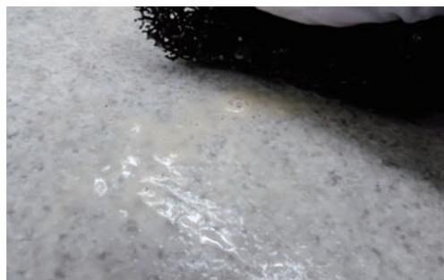
写真11 黒パッドによる剥離作業
